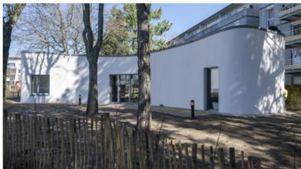
C'est à Nantes, le 21 Mars 2018 qu'une maison de 95m<sup>2</sup> conçue avec l'aide d'une imprimante 3D a vu le jour. En effet, la maison baptisée Yhno va s'est vue être l'objet d'un procédé constructif innovant les parois et murs ont été fabriqués par la technologie Batiprint 3D. C'est un changement important pour les entreprises en charge de construction de bâtiments.
