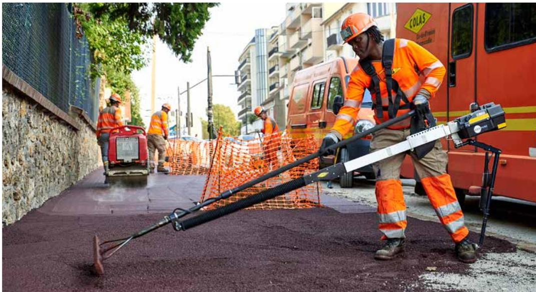
Colas s'associe à RB3D pour mettre au point un exosquelette permettant de limiter les efforts physiques répétitifs et de préserver le capital santé des ouvriers. L'outil de prise en main facile permet de pousser et tirer jusqu'à 50 kilos. Une vraie plus value en termes de prévention de la santé au travail.
